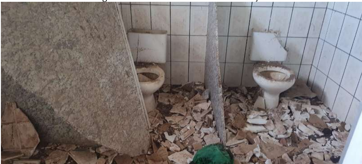
Figura 05 – Banheiro interno da edificação
