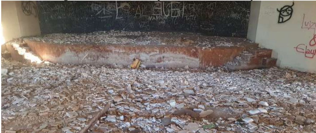
Figura 03 – Estrutura do palco do Teatro Municipal
